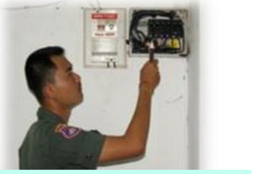
Safety Officer ตรวจสอบระบบไฟฟ้า
