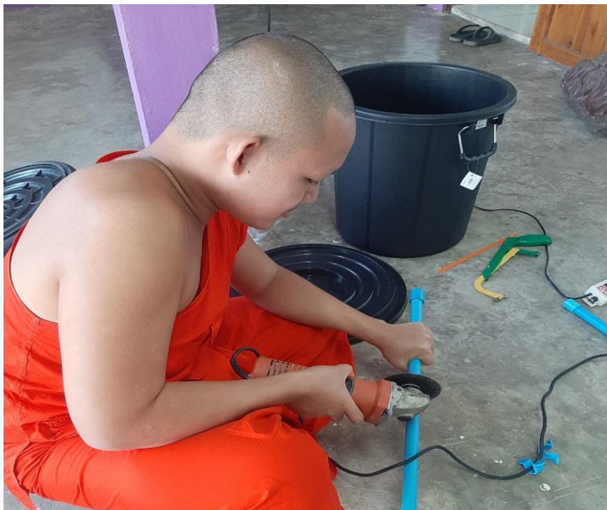
ภาพที่ 8 กำลังตัดท่อพีวีซี
